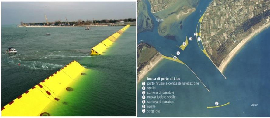
صورة (8): توضح استخدام الحواجز في مواجهة الفيضانات في مدينة البندقية
