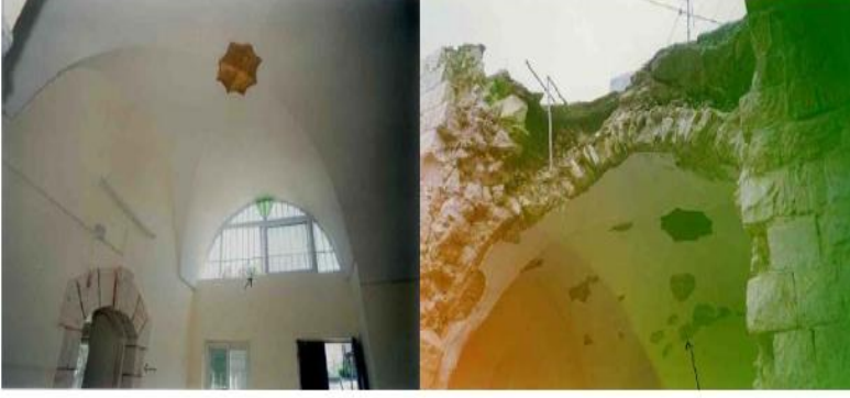
صورة (3) توضح أعمال الترميم قبل وبعد
